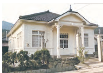
職員集会所(昭和49年に取り壊され、この地に但陽会館を建設)
