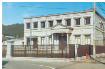
完成した職員研修所(のちの但陽会館・昭和50年12月20日)
