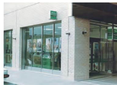
旧加古川駅前支店 (加古川サンライズビル1F S57.3撮影)
